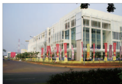
罗马尼亚娱乐中心 Entertainment Center In Romania
